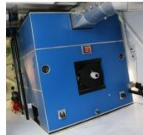
Træpillefyr til store bygninger (250 kW)
