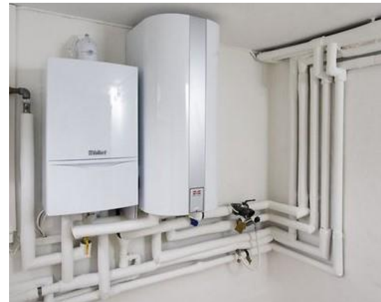
Eksempel på en opsat gaskedel (Torben Klint, 2020)
