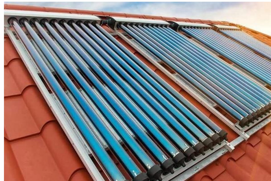
Eksempel på nogle installerede solfangere. ( Engineer.DecorexPro, 2019 )
